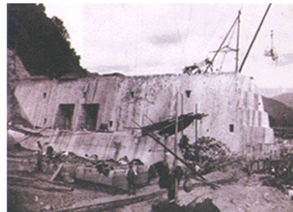
図 2 建設中の本宮砂防堰堤
