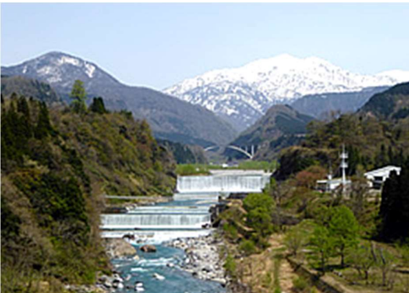
図2 本宮砂防堰堤
