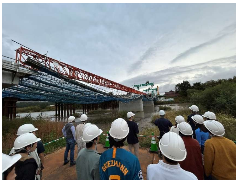
図 3 馬追橋架替工事現場を見学する参加者
