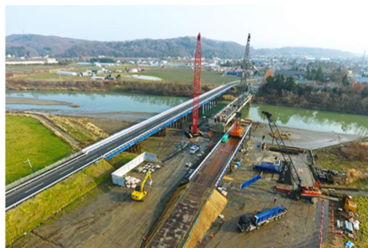
図6 馬追橋の工事の様子
