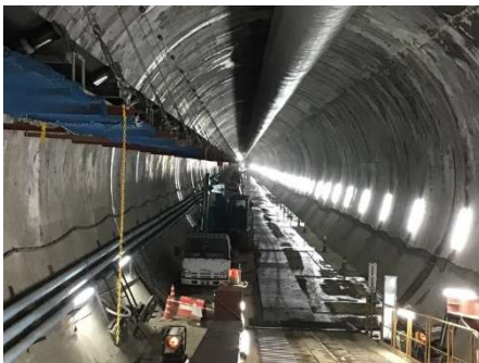
図1 羊蹄トンネルの内部
