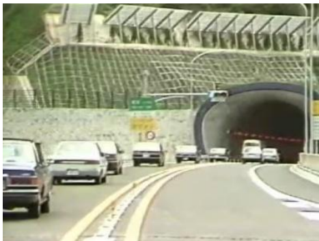
図 2 開業時の関越トンネル(暫定2車線)
