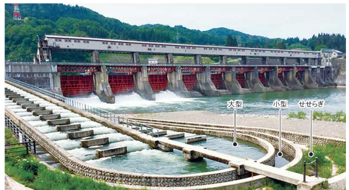
図3 魚道整備の様子(参考資料[4]より)
