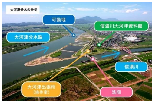
図 1 大河津分水の全景
